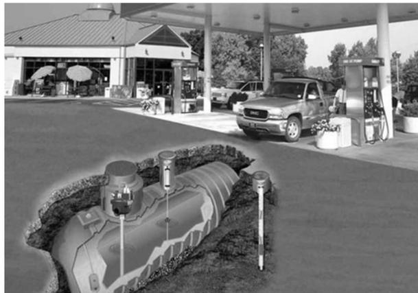
**Gambar 7. Tangki Hidrogen yang ditimbun di SPBU**
